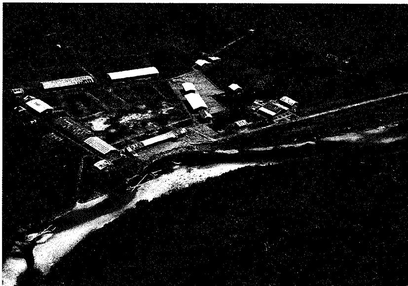
Pérdida total de vegetación originaria para la instalación de un puesto de vigilancia. Cordillera del Cóndor
